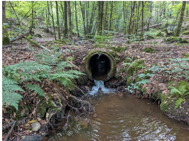
Eine von mehreren Verrohrungen
